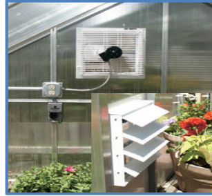
صورة (٣٠): توضح أدوات التحكم في درجات الحرارة بالصوب الزراعية
