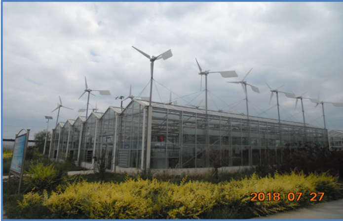
صورة (٨): منظر عام للصوبات الزراعية - النظام الآسباني - تحكم آلي يعمل بالطاقة الشمسية وطاقة الرياح
